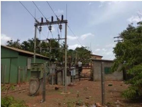
Poste 30/7 kV de Siguiiri. Au milieu de la photo le support de raccordement à 30 kV.
